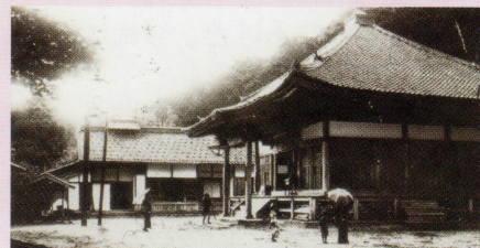
倒壊前の本堂(向こうは庫裡)
