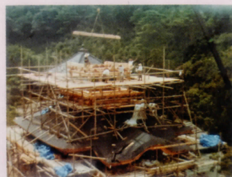
建造中の不動堂
